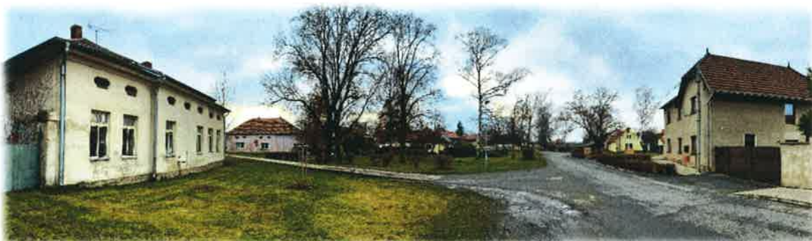
Objekt uprostřed snímku – nevhodný sklon střechy – viz detail:
