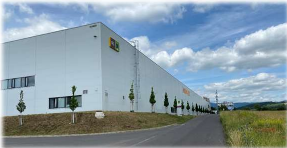
Nesprávné řešení – osázení obvodu stavby stromy
